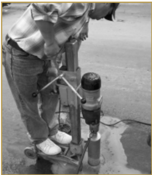
Figura 4.- Ilustración de la extracción de testigos de obra.
