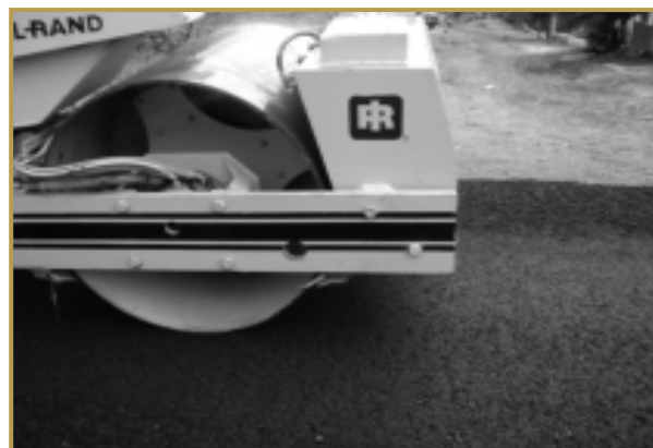
Figura 3.- Ilustración de compactación de una mezcla asfáltica.
