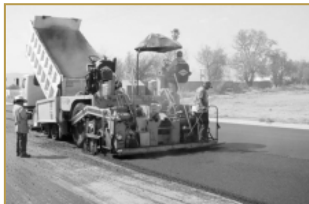
Figura 2.- Ilustración del extendido de una mezcla asfáltica.
